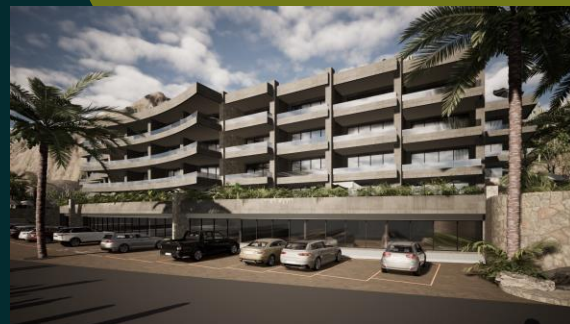
CONDOMINIOS DE CORTÉS CABO SAN LUCAS, B.C.S. 2021
